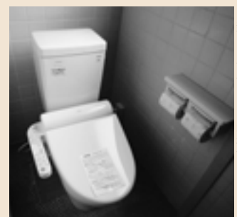
新しく設置された洋式トイレ
