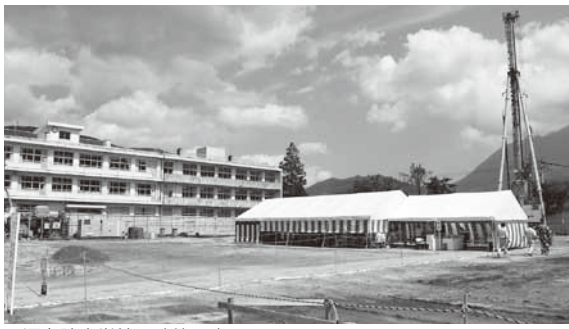
▲湯布院中学校の改築工事
