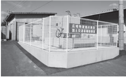
▶停電時の発電設備
