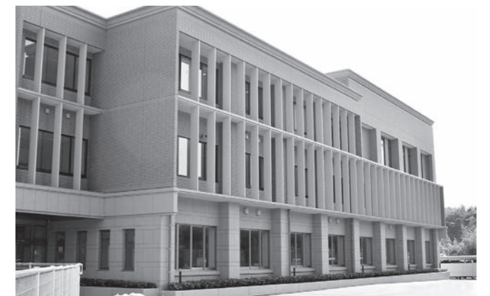
▲既存の庄内庁舎に増築された新館
