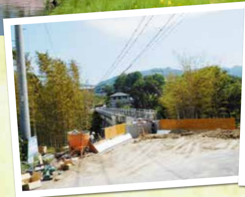
復旧中の柿原大橋
