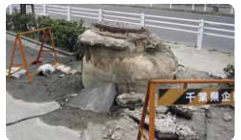
2011年／東日本大震災／浦安市高洲地区マンホール被害（消防科学総合センター）
