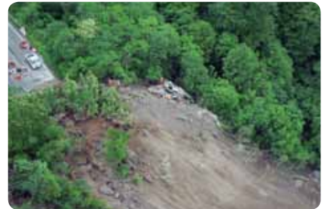
2008年／岩手・宮城内陸地震／湯浜温泉斜面崩落現場（仙台市消防局）
