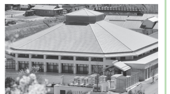
▲復旧した乙亥会館
