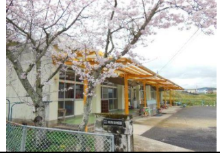
主要建物の写真
