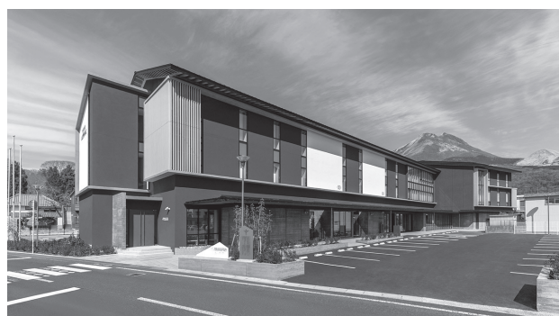
湯布院公民館（ゆふいんラックホール）
