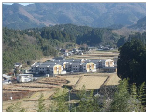
由布市営ドリームタウン五ヶ瀬住宅
