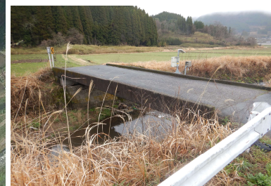
地藏橋石武側から
