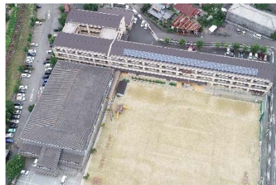
公共施設に設置している 太陽光発電システム（由布院小学校）
