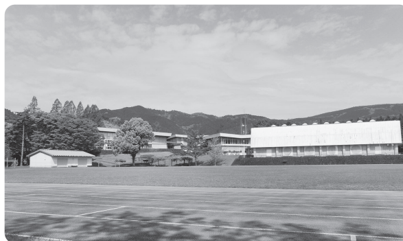
湯布院スポーツセンター
