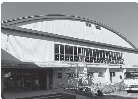
大規模改修工事中の体育館
