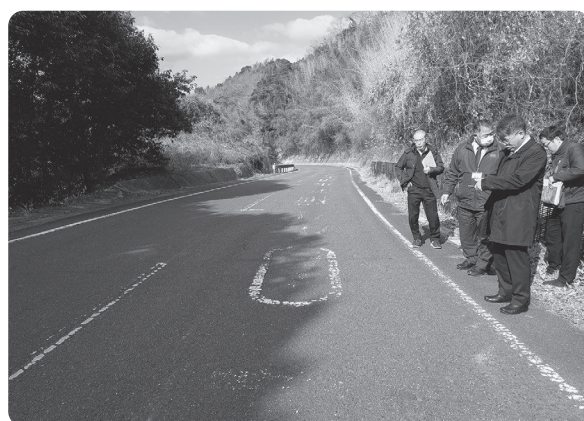
通学路安全推進会議での通学路の合同点検の場面
