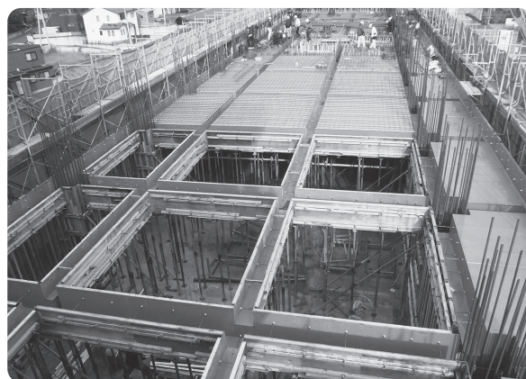
増築工事中の校舎
