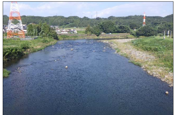
大分川中流域（狭間町天神橋）
