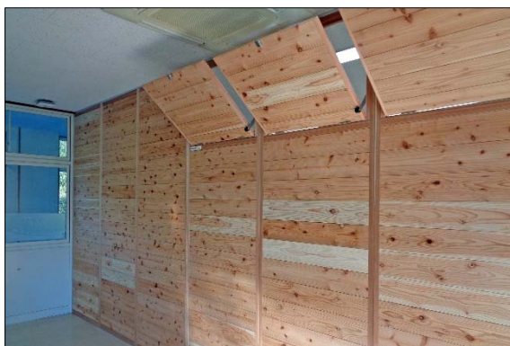
小学校教室間仕切り壁の木質化 (地域産材の活用)
