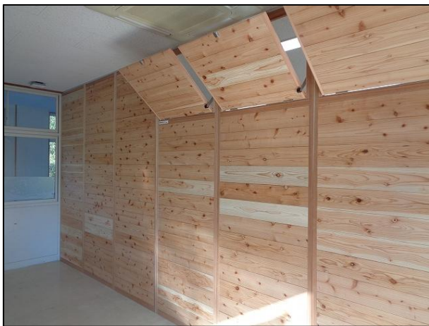
小学校の教室における間仕切り壁の木質化 （地域産材の活用）
