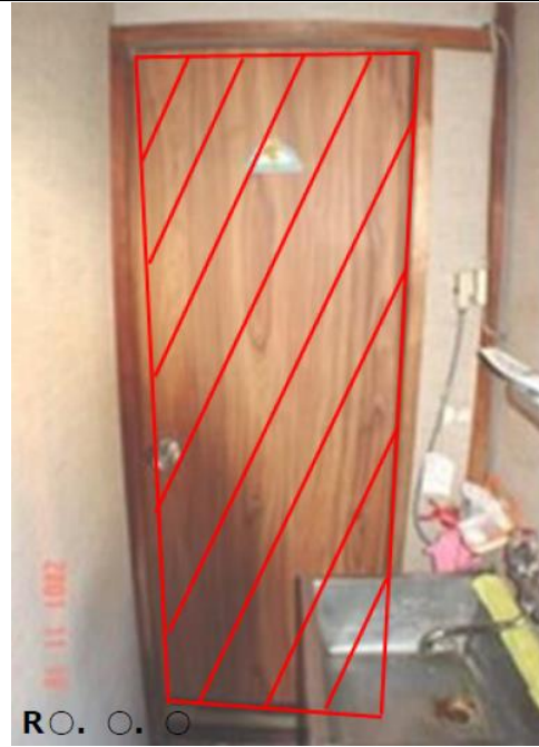
扉の取替え（改修前） 引き戸→折れ戸
