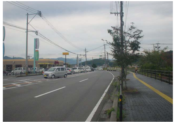
整備が進む医大バイパス線
