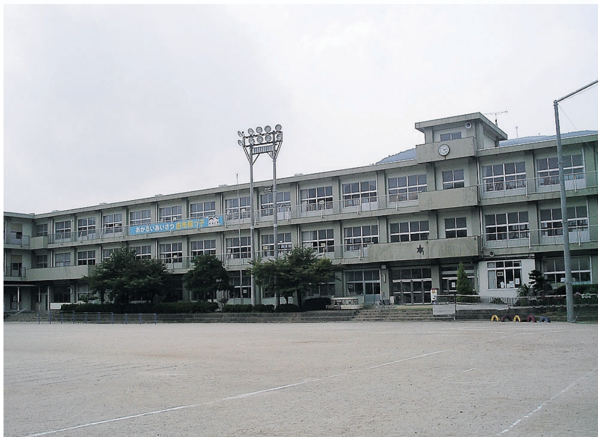
由布院小学校の建て替え工事始まる
