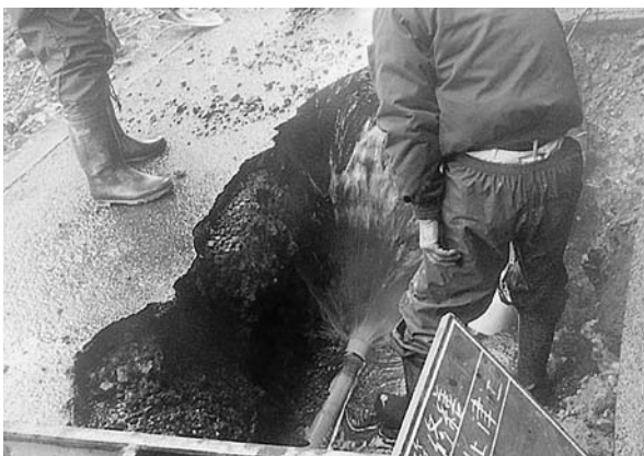
湯布院町川上 上水道配水管修繕工事
