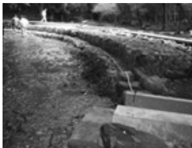
川北水源地導水管修繕
