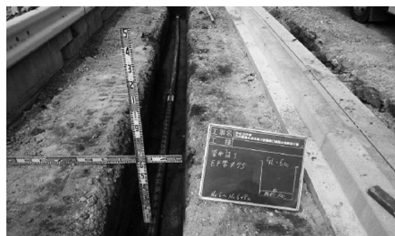
配水管更新工事(庄内町)
