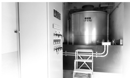
希硫酸注入設備改修工事(挾間町)
