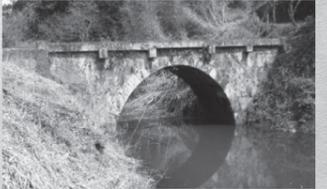
わずかな隙間を設けることで、水の逃げ道を確保しています。このように、川幅に比べて大きくどっしりとした造りや、これまで述べてきたような数々の工夫を凝らし、精緻に建造された構造から、未来永劫流されない強固な橋を架けるのだ、という当時の人々の想いが伝わってきます。
