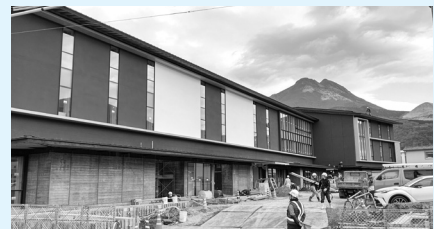
湯布院地域複合施設の外観
